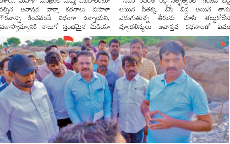
బుధవారం మునేరువాగు రిటైనింగ్ వాల్ నిర్మాణ పనులను పరిశీలిస్తున్న మంత్రి పొంగులేటి
